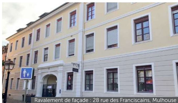
Ravalement de façade : 28 rue des Franciscains, Mulhouse
