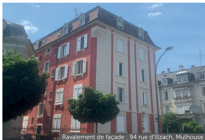
Ravalement de façade : 94 rue d'Illzach, Mulhouse
